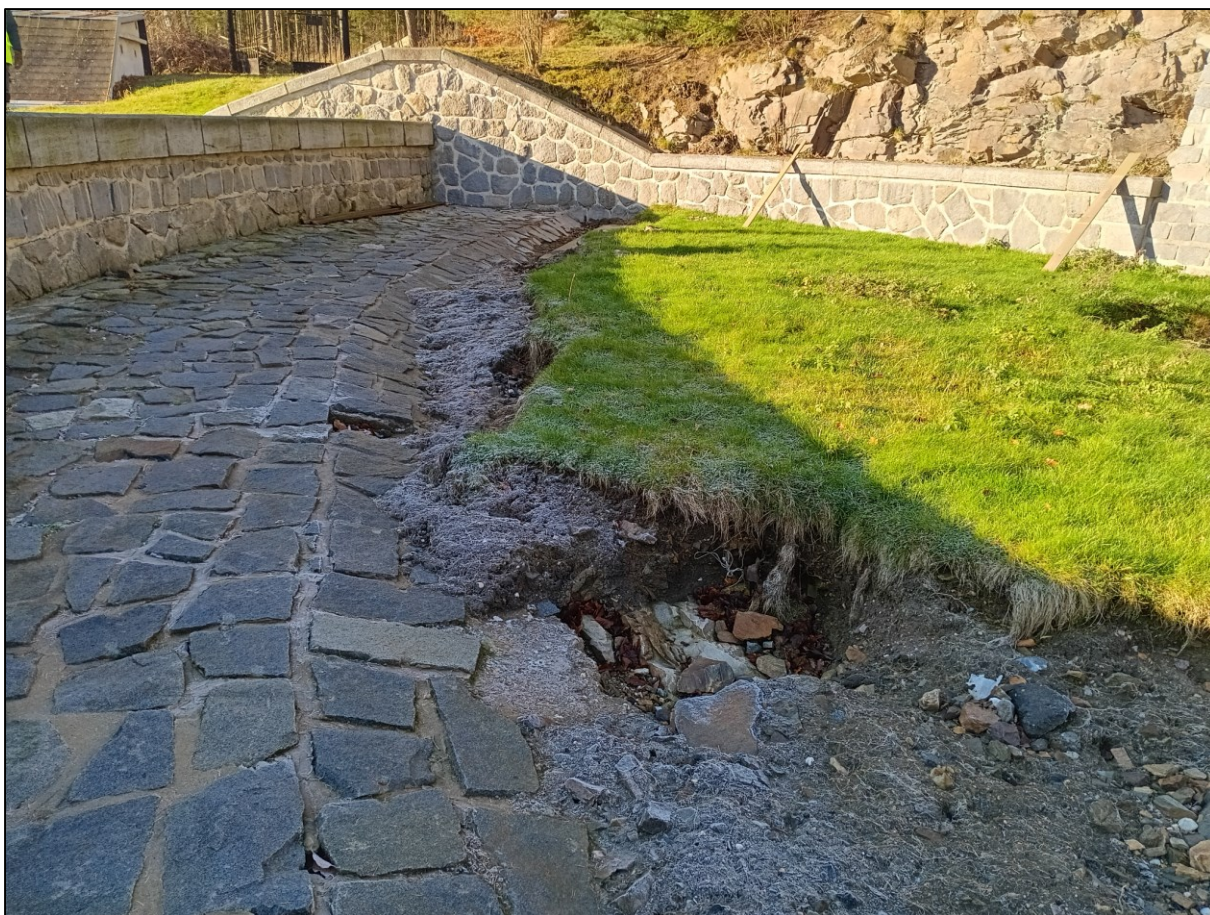
Obr. 4: Eroze jednotlivých kamenů a spárování spadiště BP, eroze travního drnu (2.12.2024)
