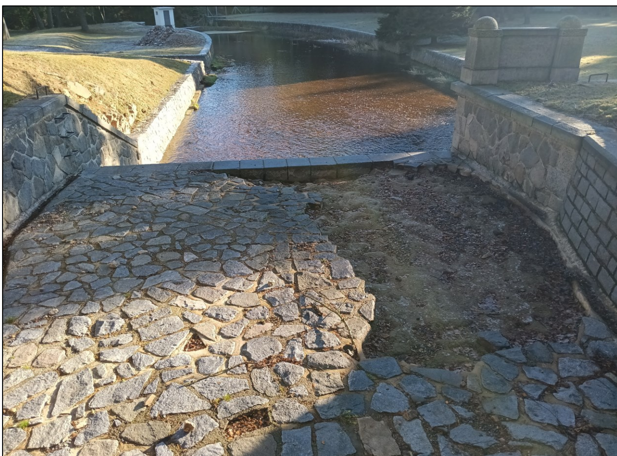
Obr. 7: Plošná eroze dlažby z lom. kamene na posledním stupni spadiště (2.12.2024)
