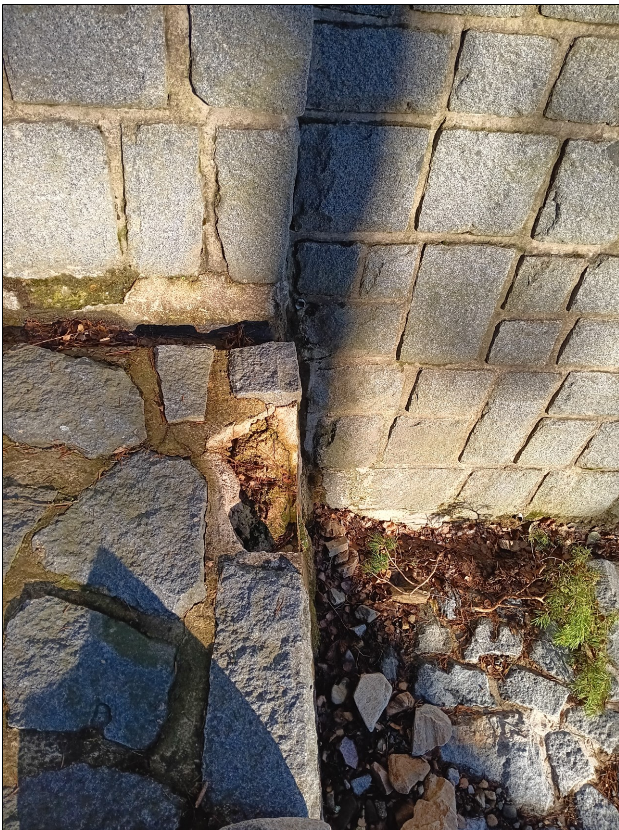
Obr. 8: Dílčí erodované kameny a poruchy spárování na jedn. stupních kaskády (2.12.2024)
