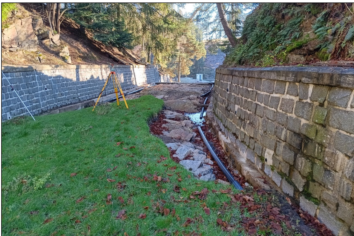
Obr. 5: Eroze travního drnu ve dně skluzu od BP (2.12.2024)
