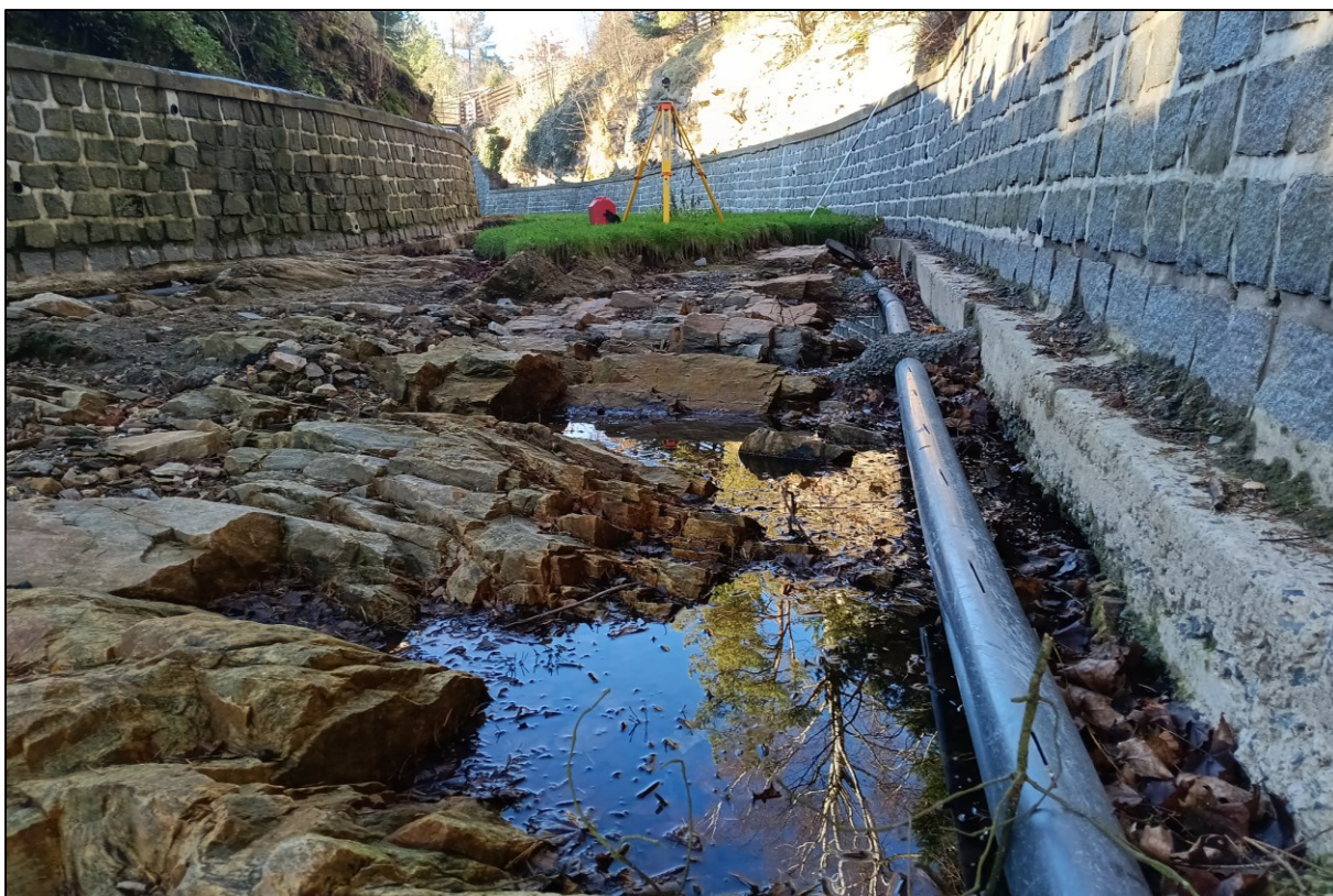
Obr. 6: Eroze travního drnu ve dně skluzu od BP (2.12.2024)
